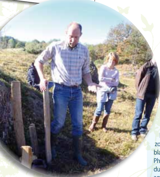
Un des agriculteurs adhérents avec une des pompes de pâture installée en zone sèche avec prélèvement d'eau (crépine) dans le ruisseau principal. La tranchée (30 cm x 30 cm) de passage du tuyau PEHD a été rebouchée aussitôt.
