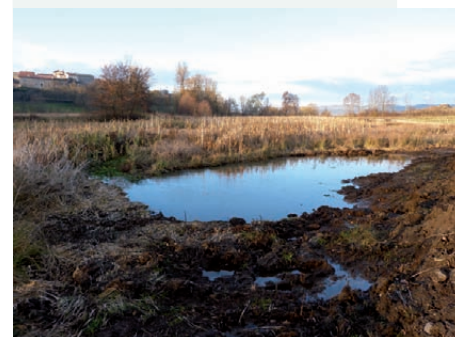
La nouvelle mare, un mois après les travaux.
