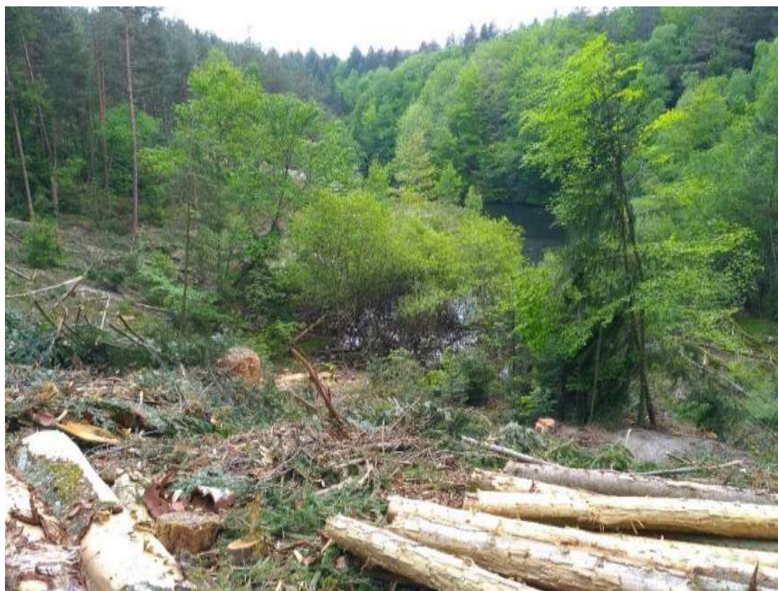
Le site avant travaux (mai 2023)
