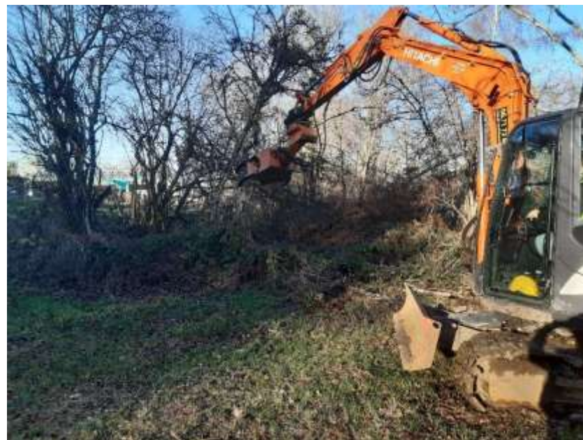
Opérations de déboisement et défrichage d'une partie du pourtour de l'étang
