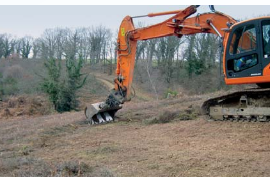
Travaux d'écimage et d'étrépage des landes de Nerdre, janvier 2011.
